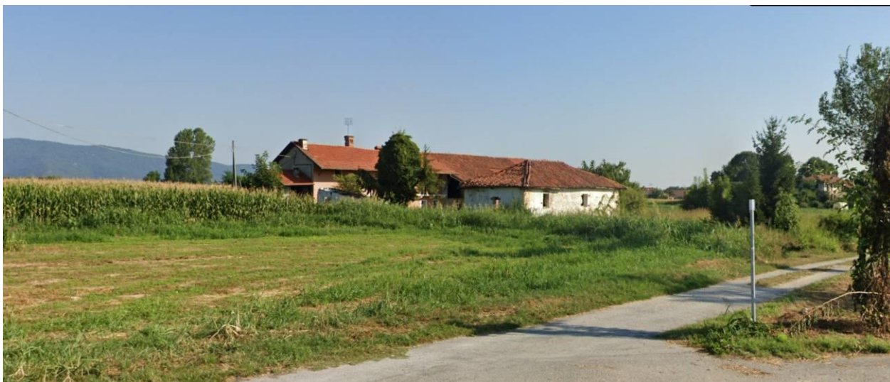
Vista in direzione nord dell'edificio in oggetto (da Via Maccagno ang. Via Pituchet)
