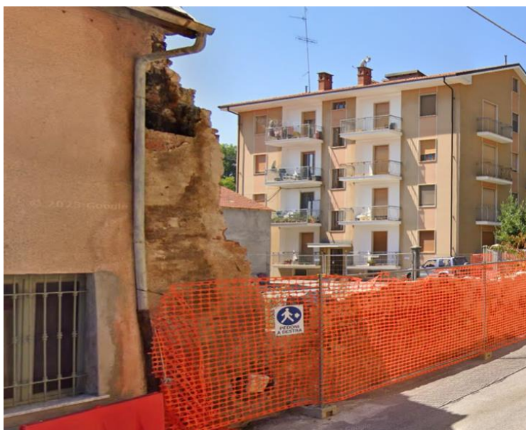
Vista dell'intervento di demolizione in corso di esecuzione
