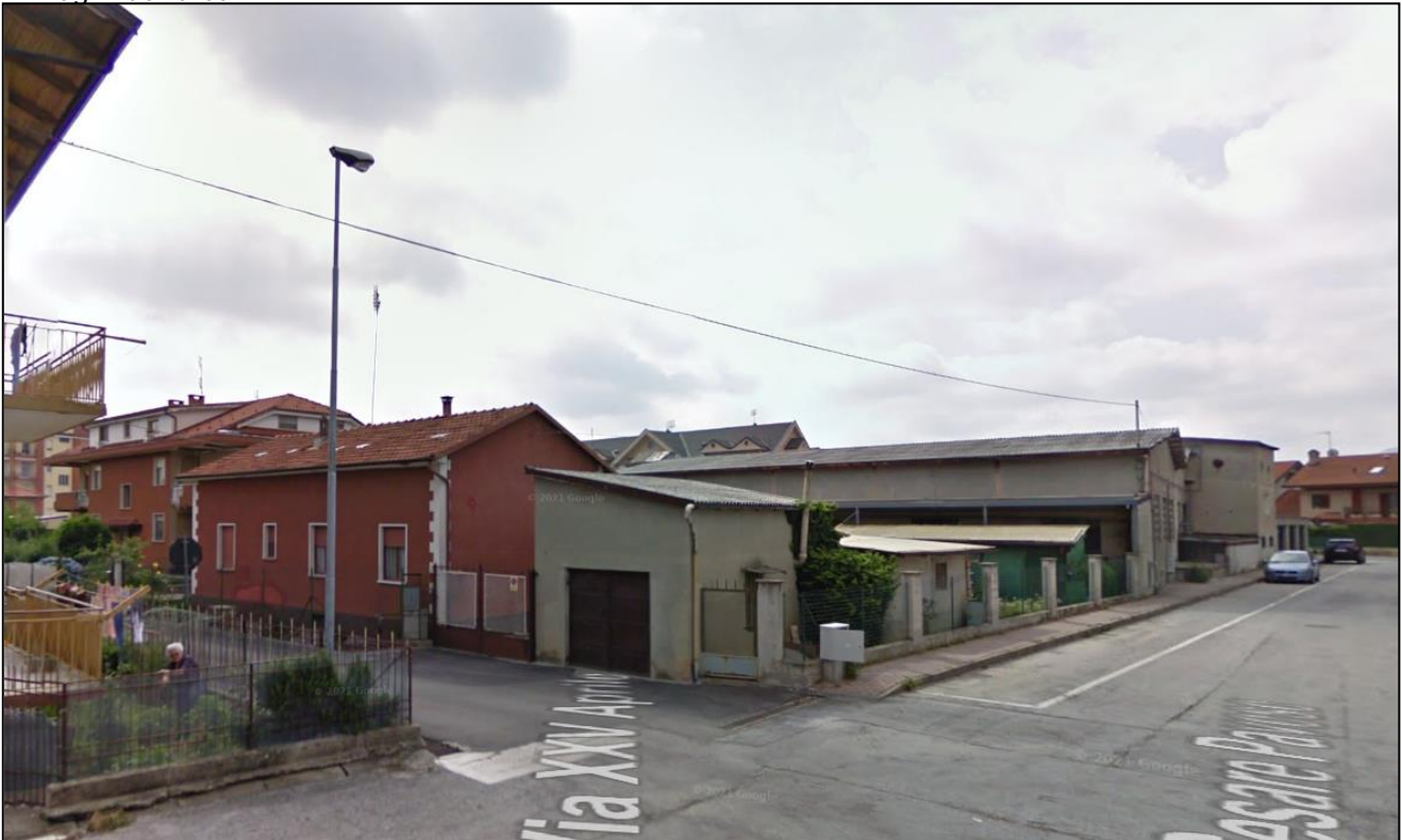
Vista verso sud-est dell'edificio oggetto di modifica da Via Cesare Pavese
