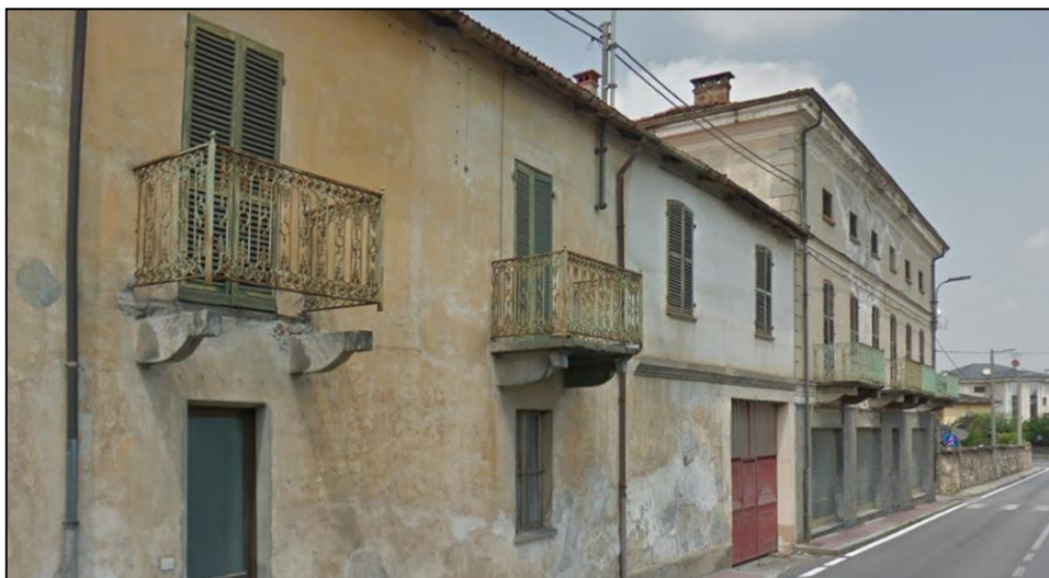
Vista in direzione nord da Via Matteotti
