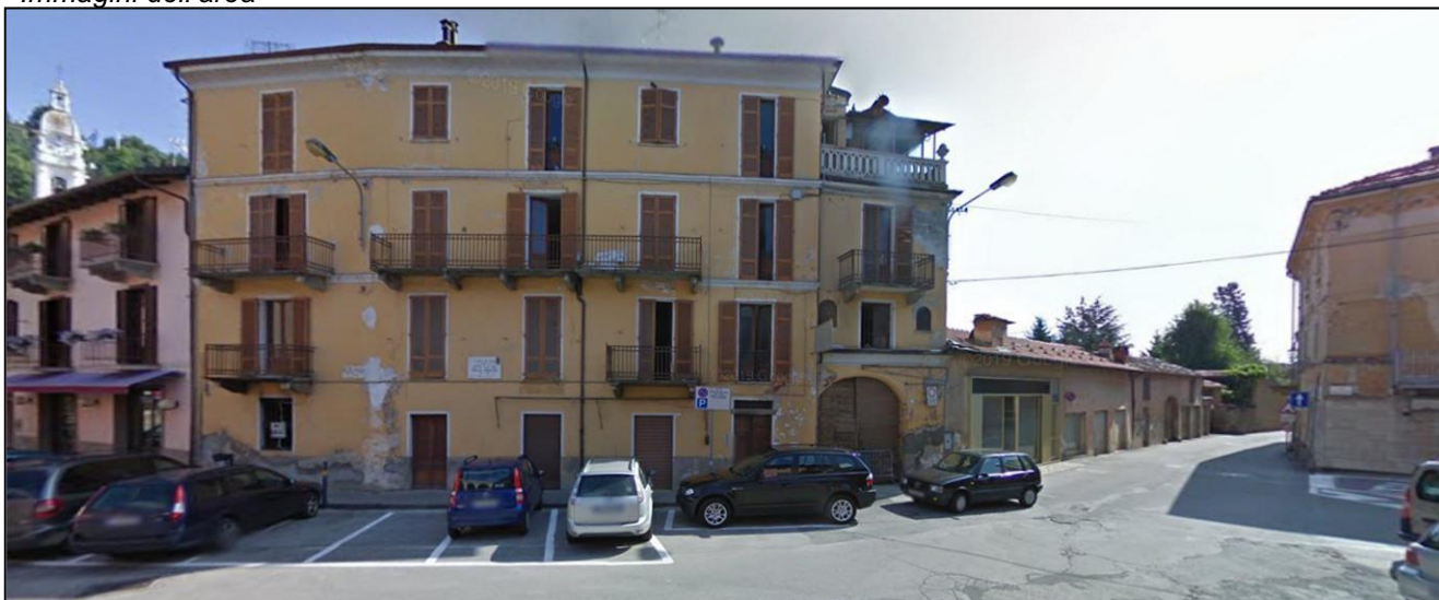
Vista in direzione nord-est dell'area (da piazza Cavour)
