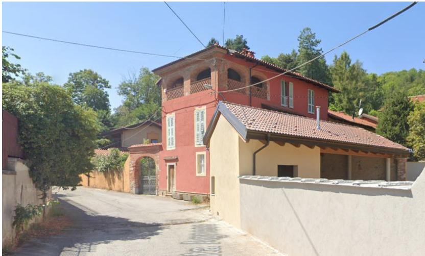
Vista in direzione sud-ovest dell'edificio in oggetto (da Via Sant'Agnese)
