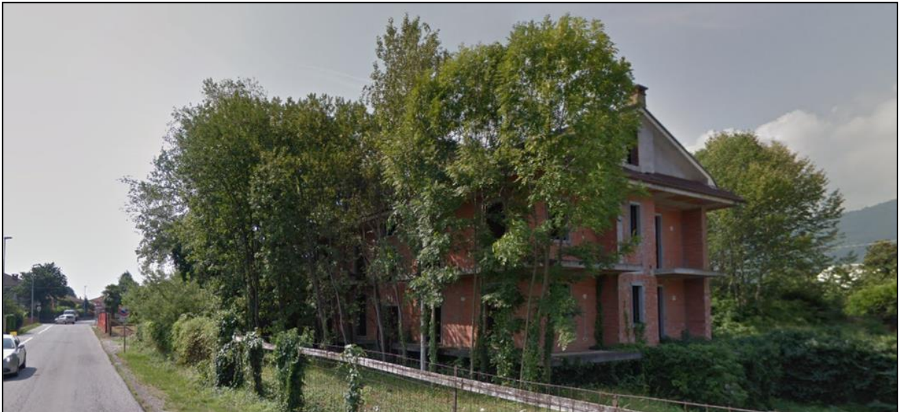
Vista dell'area oggetto di modifica verso sud-ovest da Via Torino
