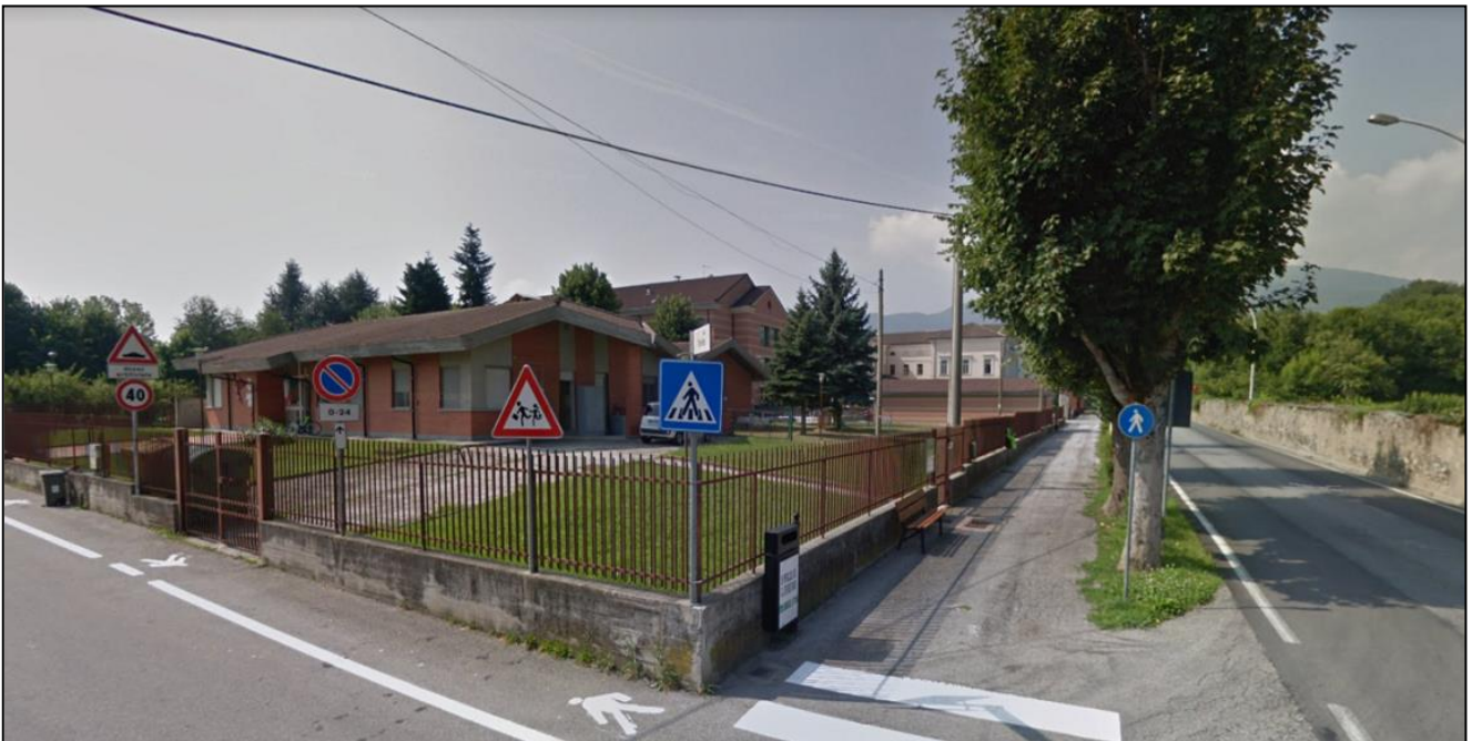
Vista in direzione sud dell'area da Via Valgrana ang. Via Torino
