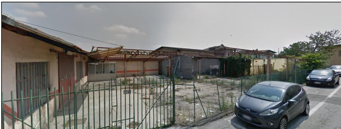
Vista dell'area oggetto di modifica verso est da Via Vecchia di Cuneo (porzione nord)
