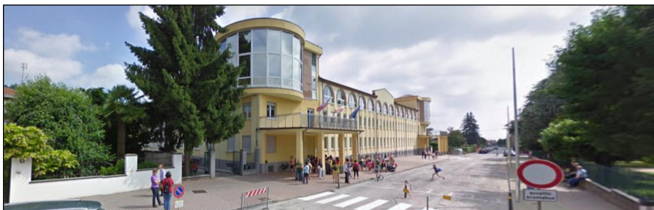
Vista in direzione est dell'area da corso Giovanni XXIII
