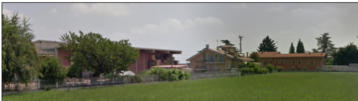
Vista dell'area oggetto di modifica verso est da Via Rittanolo
