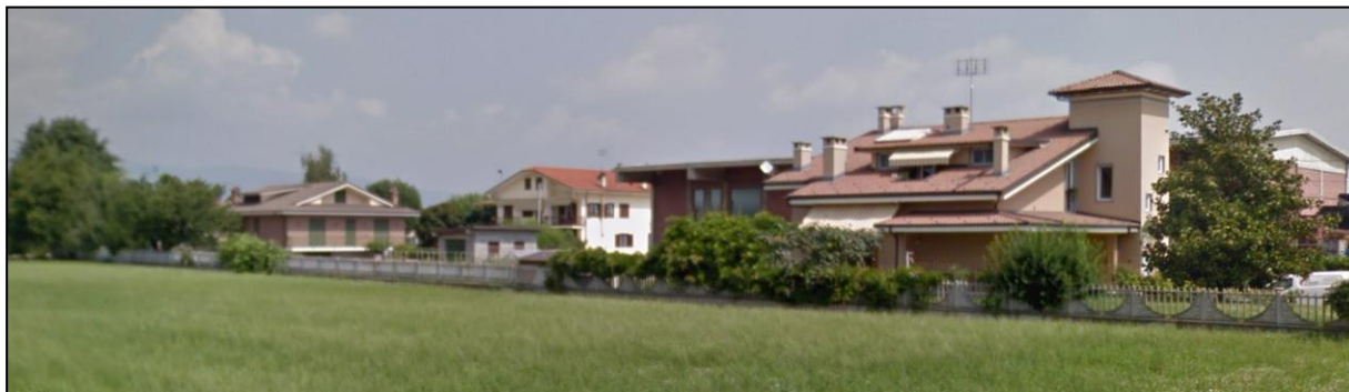
Vista dell'area oggetto di modifica verso nord da Via Camposanto
