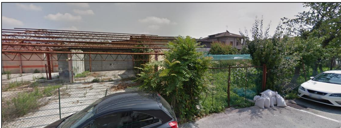
Vista dell'area oggetto di modifica verso est da Via Vecchia di Cuneo (porzione sud)
