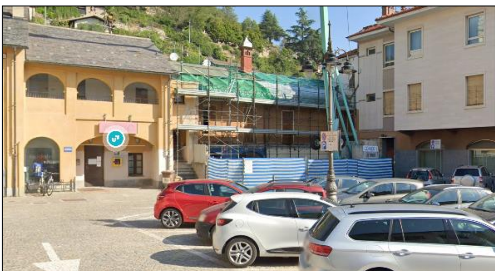
Stessa vista precedente, ma dell'intervento di demolizione della superfetazione, autorizzato e in corso di esecuzione
