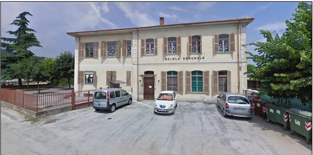
Vista in direzione nord dell'area da Via Paschera San Carlo
